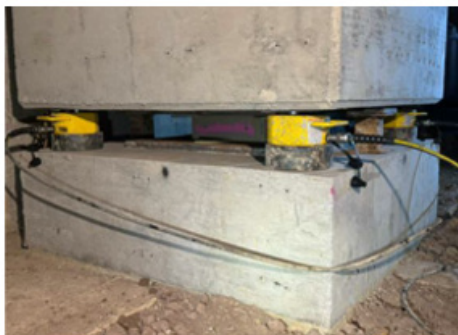
Colocación de gatos y apoyos de seguridad
