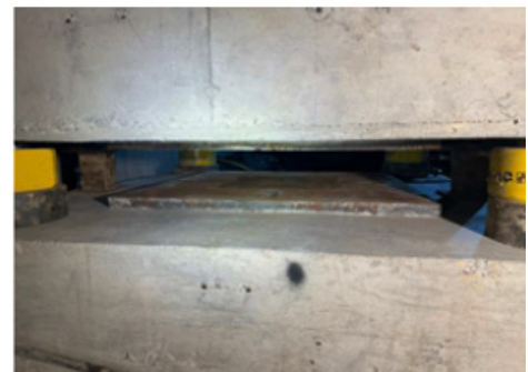
Retiro del apoyo temporal
