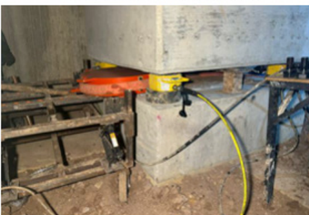
Colocación del aislador sísmico
