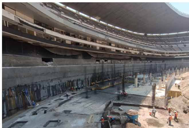
Figura 5. Estructuras aledañas al nuevo graderío bajo
