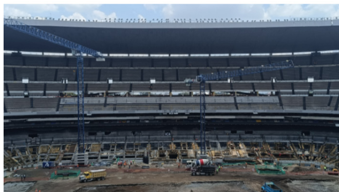
Figura2. Etapa Constructiva Graderío Bajo Este
