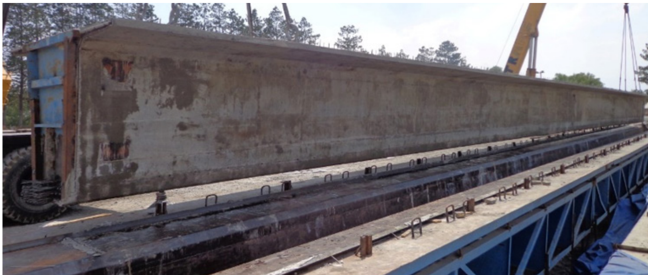
Figura 2. Molde (cimbra metálica) para trabe cajón pretensada.
